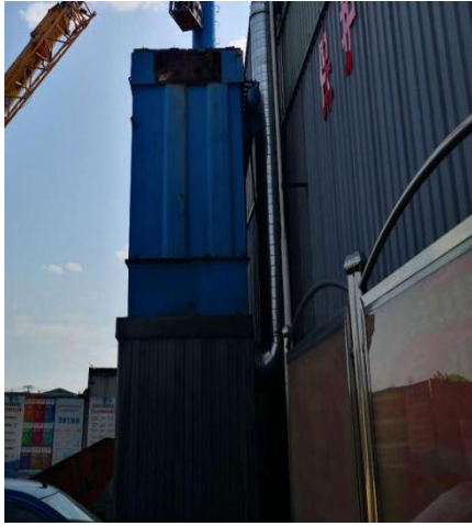
图 4-2：浇铸、造型、落砂、砂再生、混砂粉尘废气：布袋除尘器+15m 排气筒
