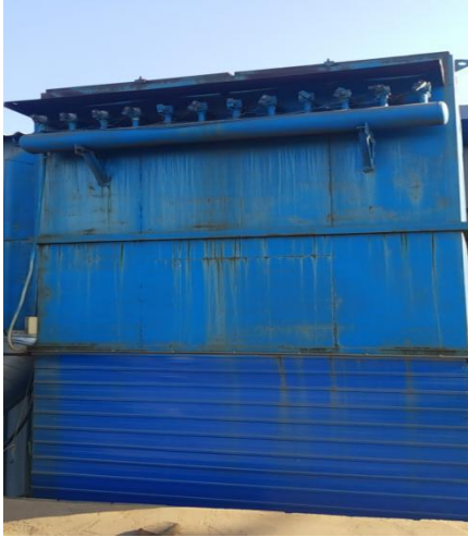
图 4-1：电炉熔化废气：布袋除尘器+15m 排气筒
