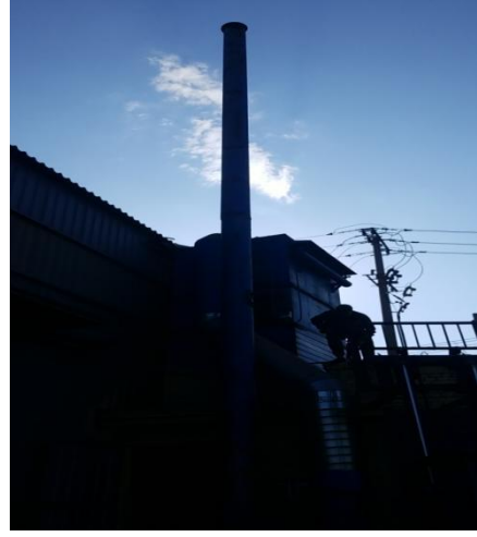
图 4-1：电炉熔化废气：布袋除尘器+15m 排气筒
