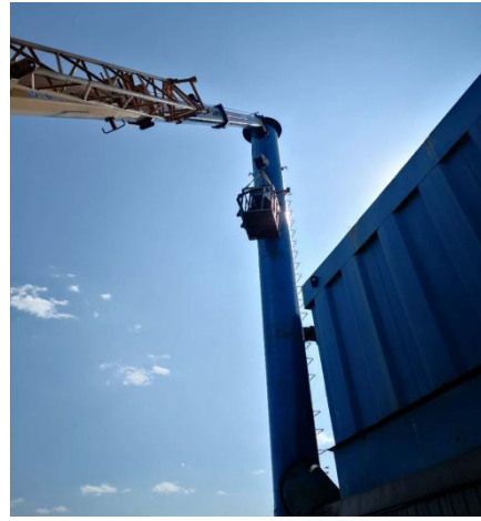
图 4-2：浇铸、造型、落砂、砂再生、混砂粉尘废气：布袋除尘器+15m 排气筒
