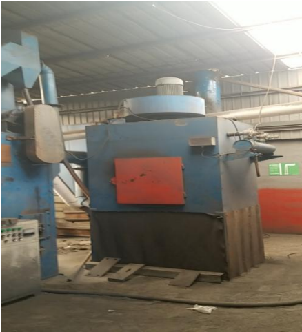
图 4-3：抛丸清砂、打磨废气：布袋除尘器+15m 排气筒
