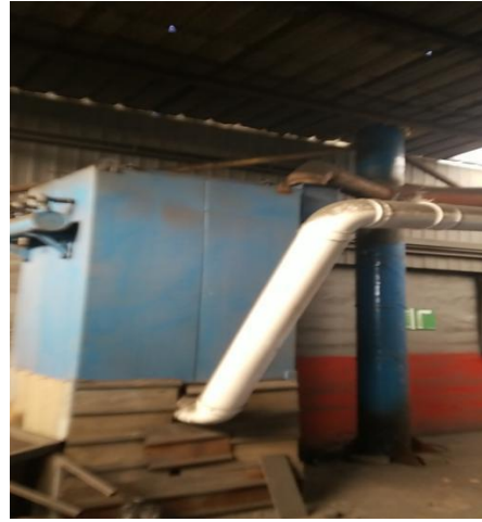
图 4-3：抛丸清砂、打磨废气：布袋除尘器+15m 排气筒
