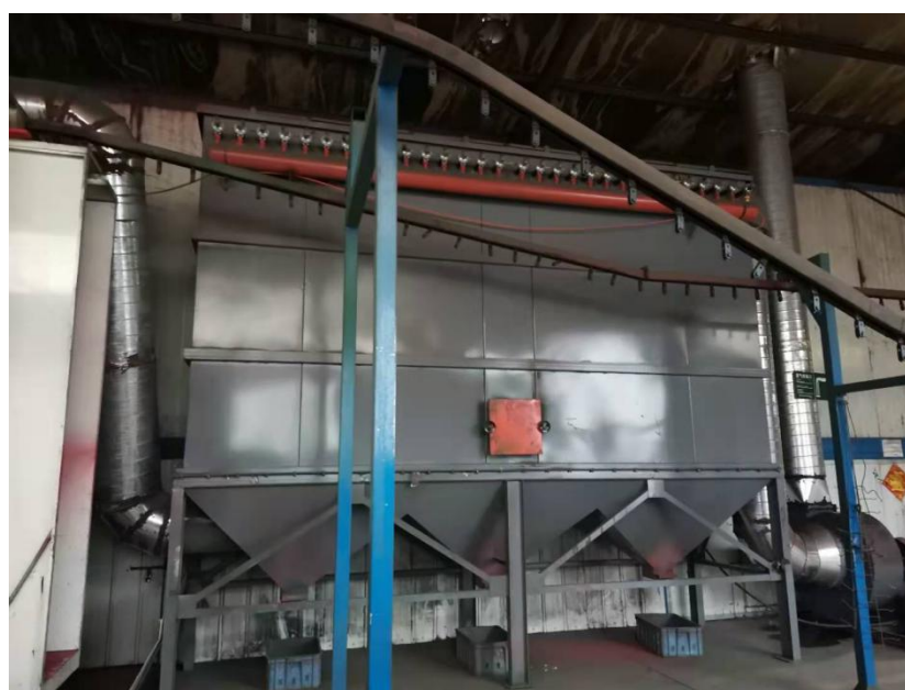
图 4-2 喷涂工序：滤筒除尘+脉冲式布袋除尘器+15 米排气筒
