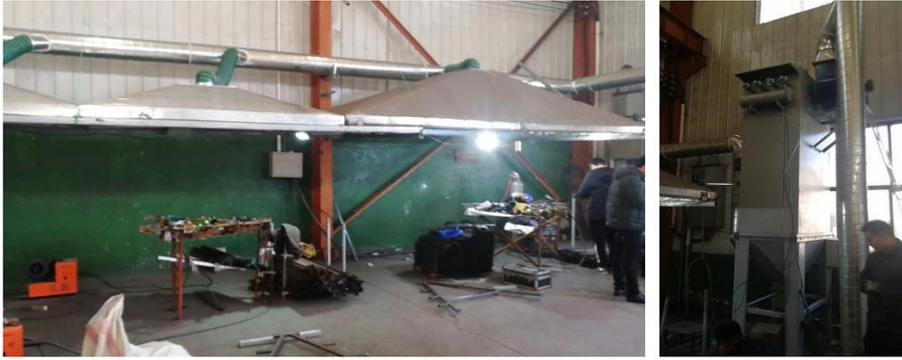
图 4-1 焊接工序废气处理设施
